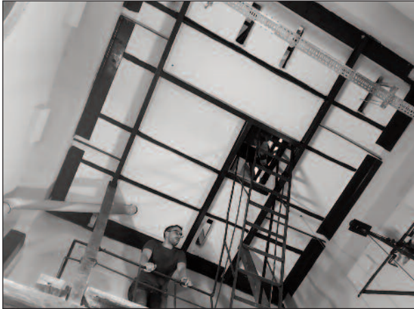
Blick auf das interne Stahlgerüst gegen Erdbeben
