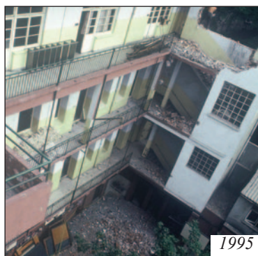
Abbruch der Mauer (incl. Stiegengebäude) zur Mädchenschule
